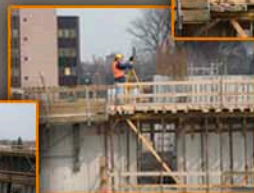
Rilievo e tracciamento Stazione terminale nord S.I.R. (PD)
